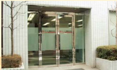
ビーエム機器株式会社本社 (東京都文京区)
